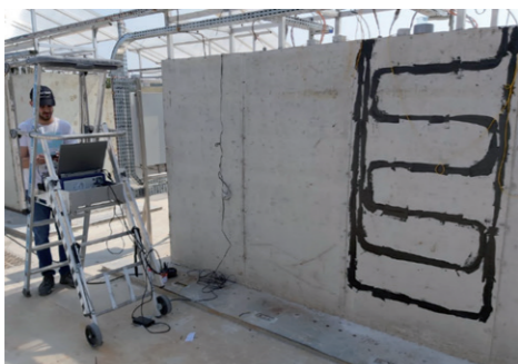
Instrumentation par capteurs à fibres optiques collés en surface du bloc KB (Juillet 2019)
